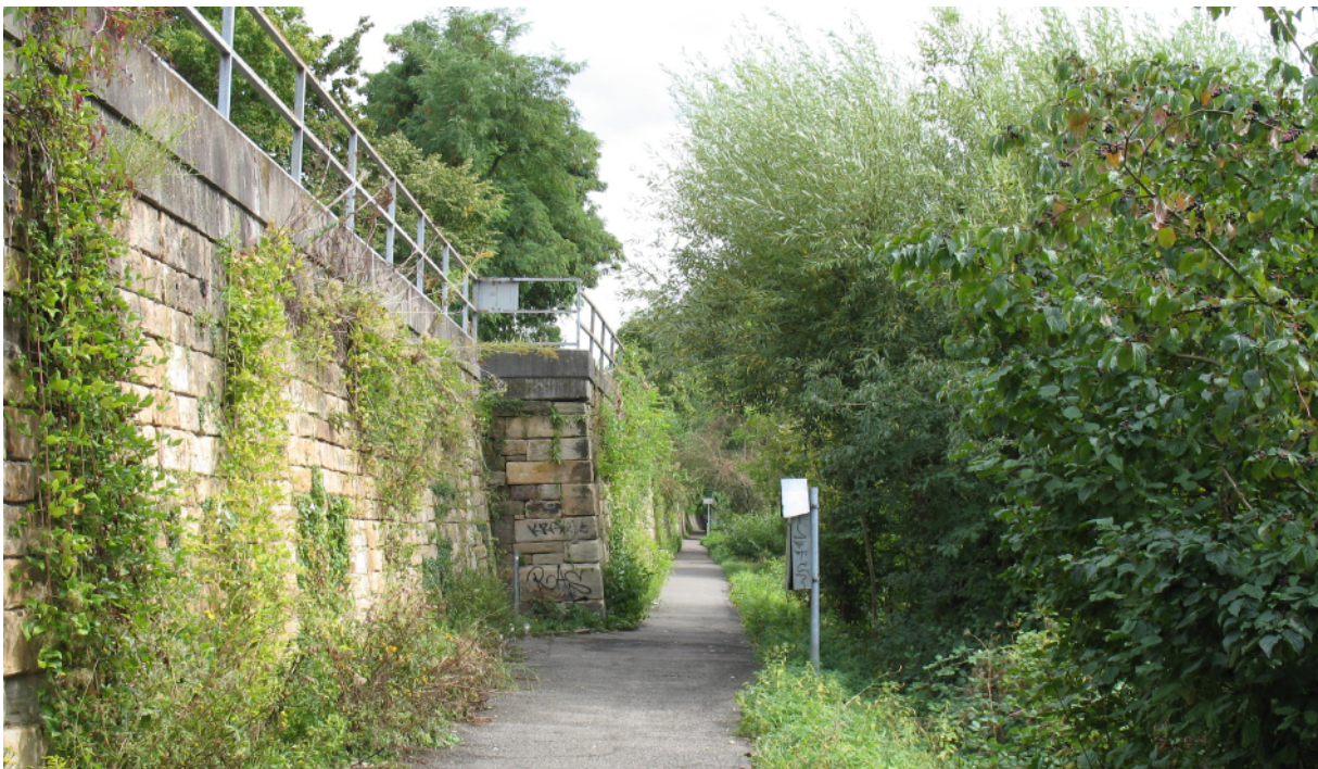
Abb. 16: Einengung des Neckartalradwegs im Bahnhofsbereich
