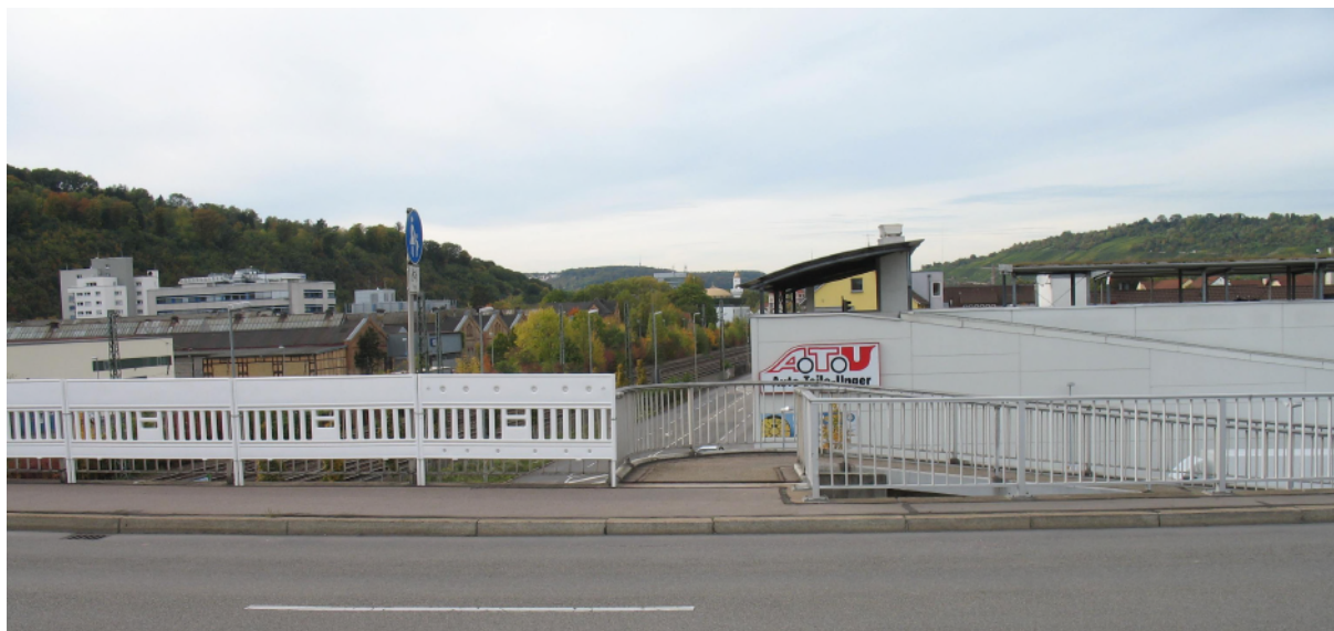
Abb. 17: Geländer der Adenauerbrücke
