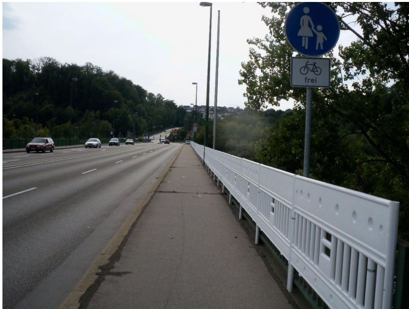
Provisorium zur Geländererhöhung in Esslingen
