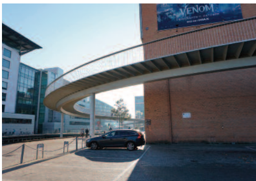
Die „Cykelslangen-Brücke“ – 300 m lang und ausschließlich für den Radverkehr ; Fotos: Dieter Seifried
