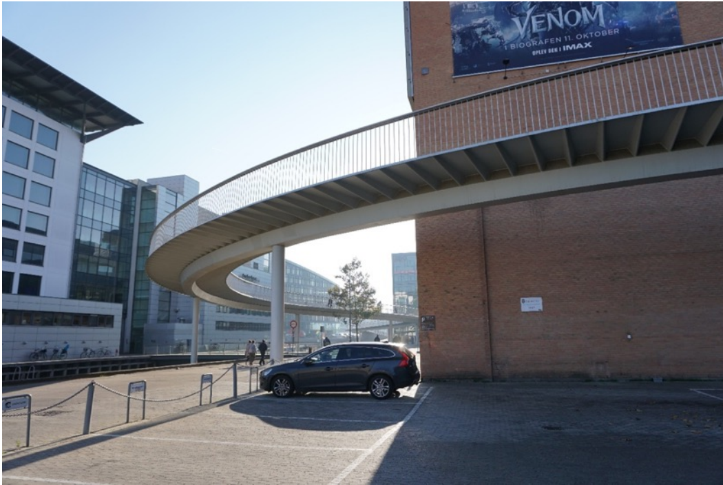
Die „Cykelslangen-Brücke“ – eine 300 m lange Brücke ausschließlich für den Radverkehr
