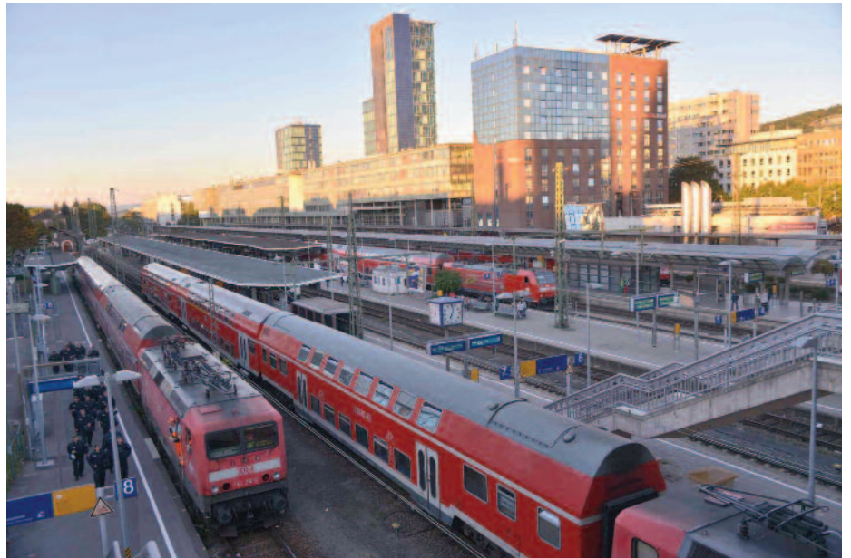
Das Zentrum der regionalen Mobilität: In Zukunft werden am Freiburger Hbf. dank Breisgau-S-Bahn 2020 deutlich mehr Menschen ein-, aus- und umsteigen. Foto: Jörg Dengler
