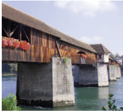
Bad Säckingen, Gedeckte Holzbrücke Foto: Taxiarchos228/Wikipedia
