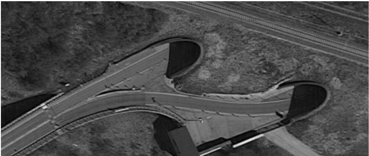
Satellitenbild der westlichen Tunnelleinfahrten
